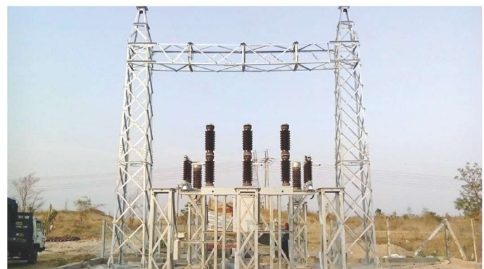
33kV Switchbay Extension(Under Construction) 112(T)/ESE/2014-2015
